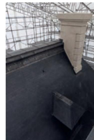
À Vincennes, les travaux de rénovation du clos et du couvert du pavillon de la Reine se sont poursuivis dans le cadre du protocole Culture – Défense. Ces travaux consistent à effectuer un ravalement de la façade, un changement des fenêtres avec double vitrage, un changement de la couverture et l'isolation des combles.
