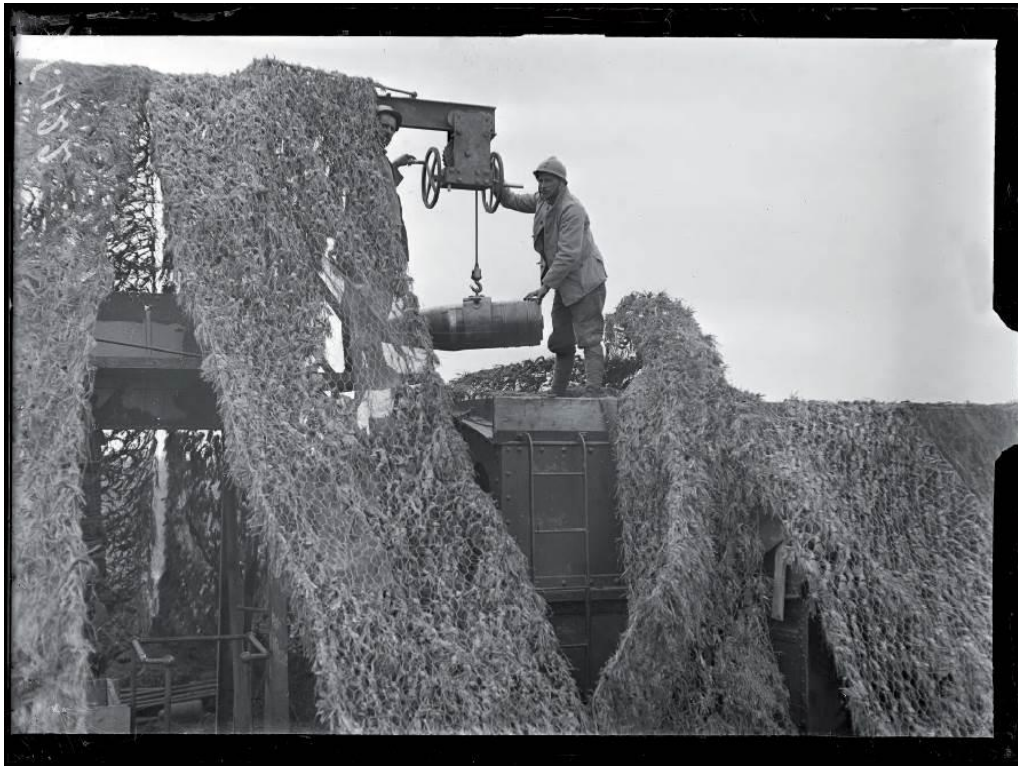
Harbonnières (Somme). Canon de 305 mm. Sortie à l'aide d'un treuil de l'obus, du wagon à munitions. Août 1916. Pierre PANSIER/ECPAD/Défense.
